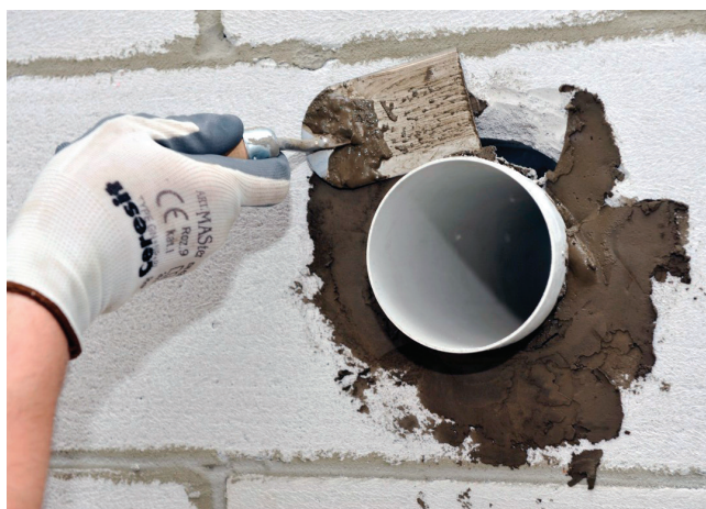
Montaż za pomocą zaprawy CX 5
